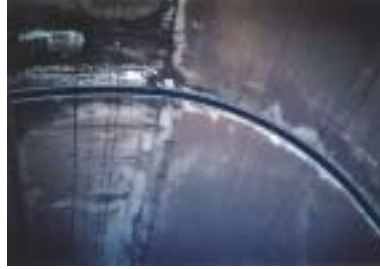
エバドレン取付後
