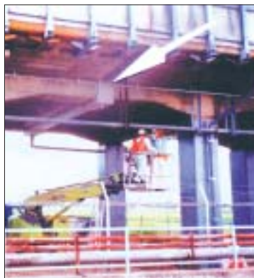
高架橋天井部分取付
